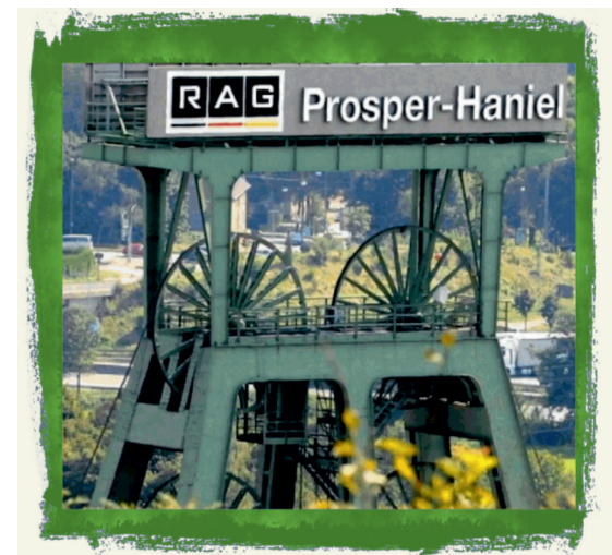
Schacht Franz Haniel des letzten Bergwerks in NRW. Prosper-Haniel wurde zum 31.12.2018 stillgelegt. Damit endete die 150-jährige Steinkohlenförderung in Deutschland
